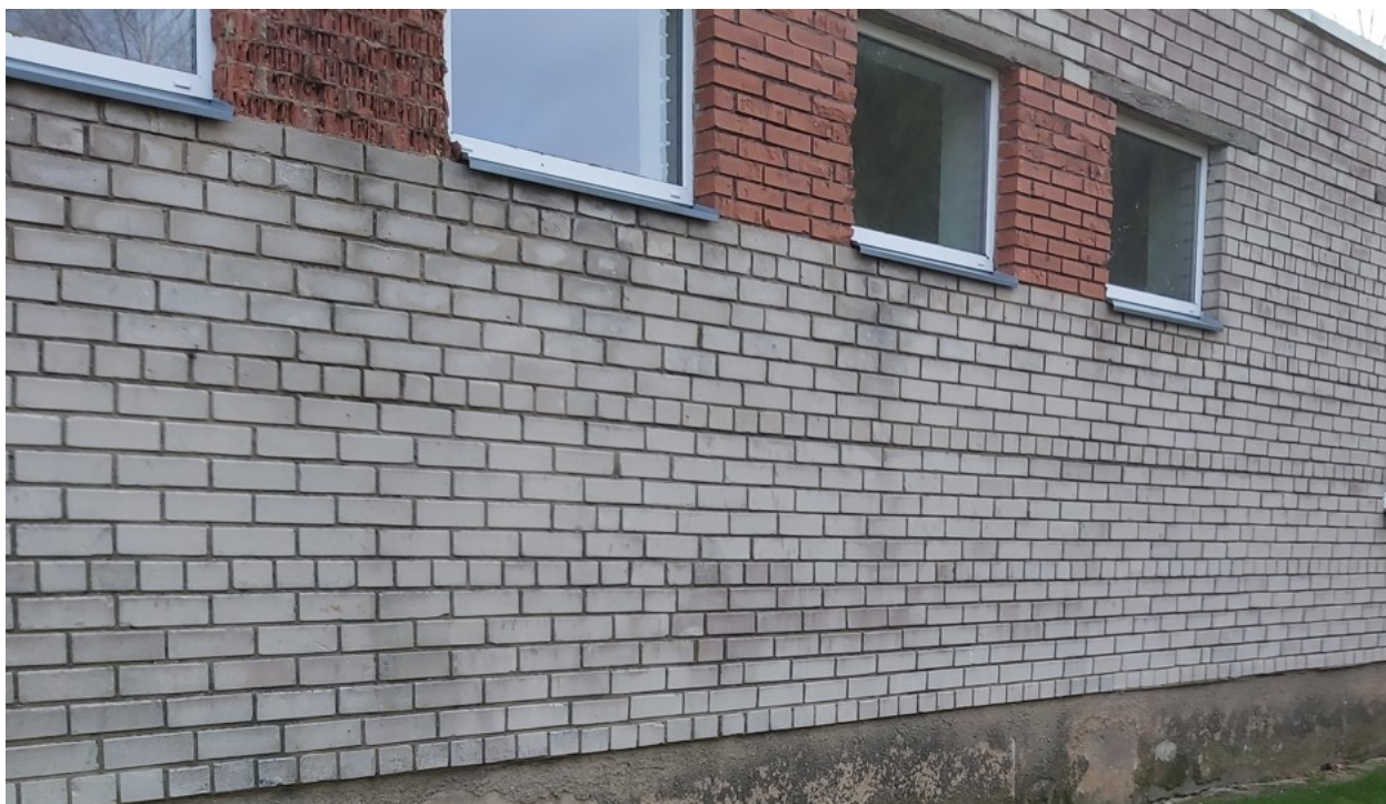
1 pav. Remontuojamo pastato fotofiksacija (2020-11 mėn.).
