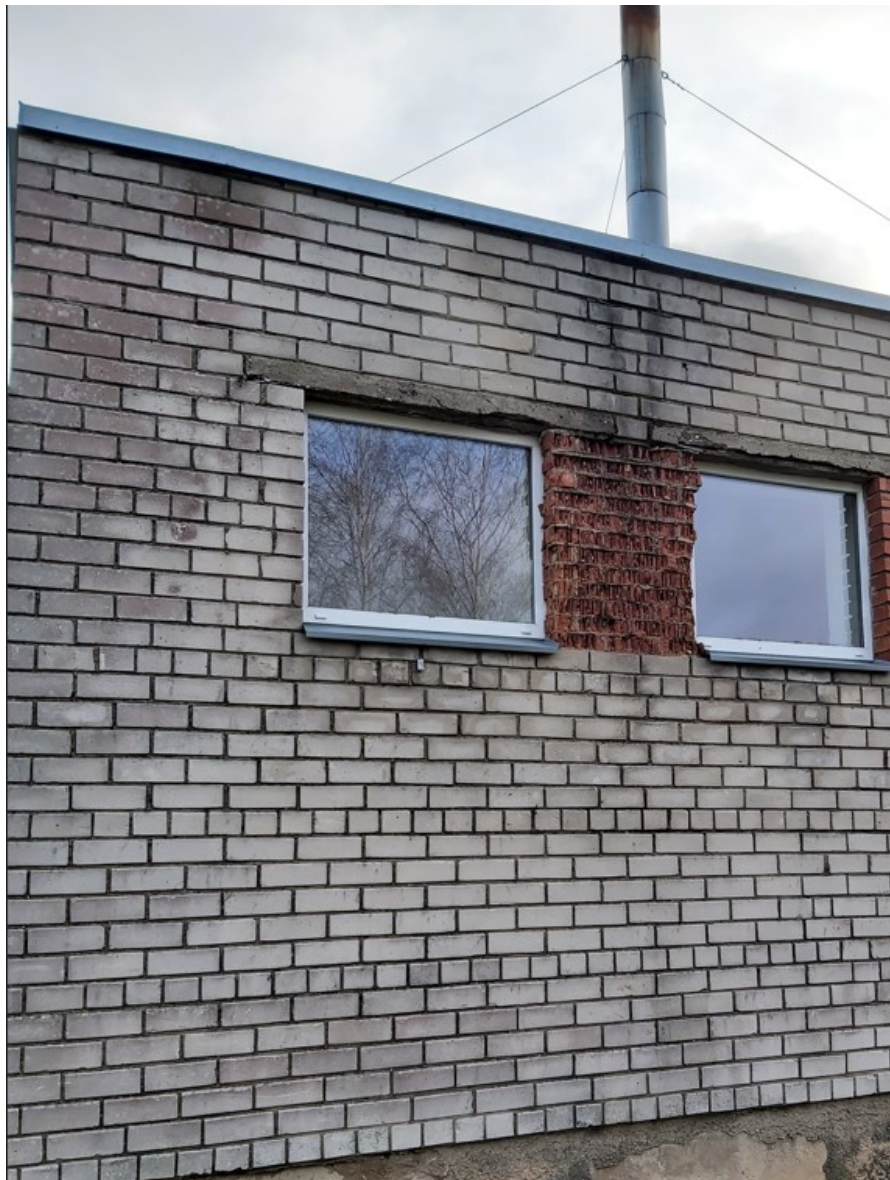
3 pav. Remontuojamo pastato fotofiksacija (2020-11 mėn.).
