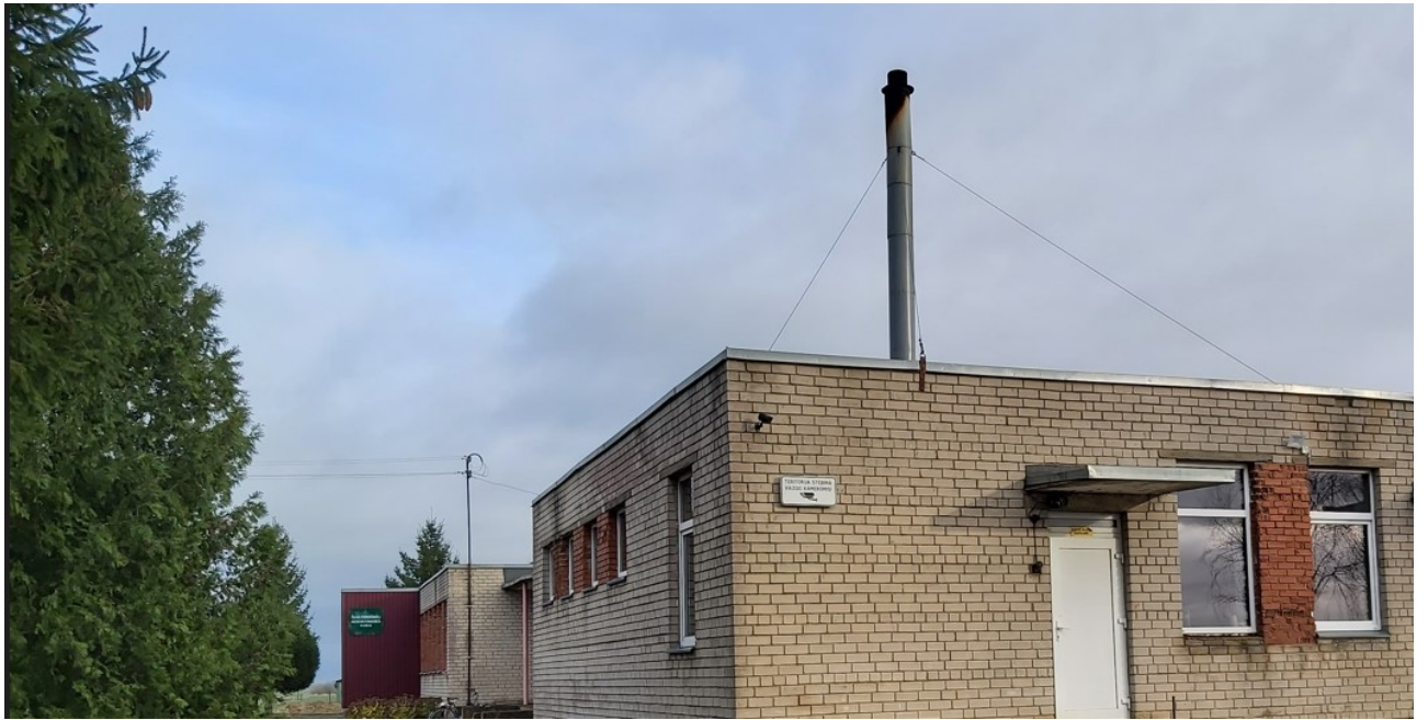
2 pav. Remontuojamo pastato fotofiksacija (2020-11 mėn.).
